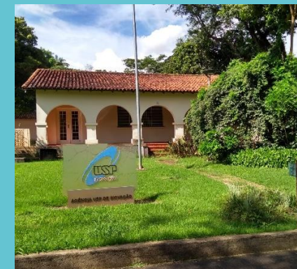
Foto da casa onde está instalada a AUSPIN-RP: arquivos PUSP-RP
